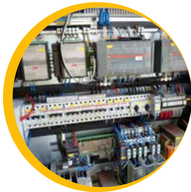
REPARACIÓN DE VARIADORES DE FRECUENCIA, PLC's Y TARJETAS ELECTRÓNICAS
